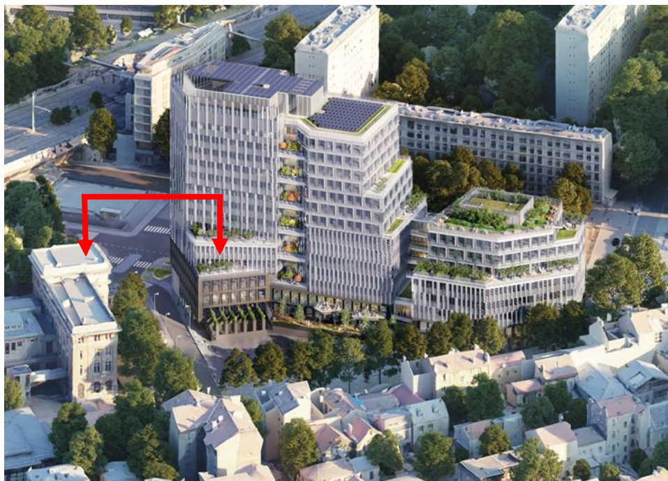
Figure 13 : Vue du nouveau bâtiment depuis Malakoff, mettant en avant l'équivalence de hauteur entre le bâtiment de l'université et les terrasses du nouveau bâtiment
